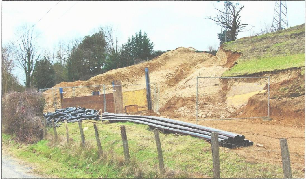
■ Depuis le chemin de la Déserte, les travaux sont impressionnants. Photo Johan BOZON
