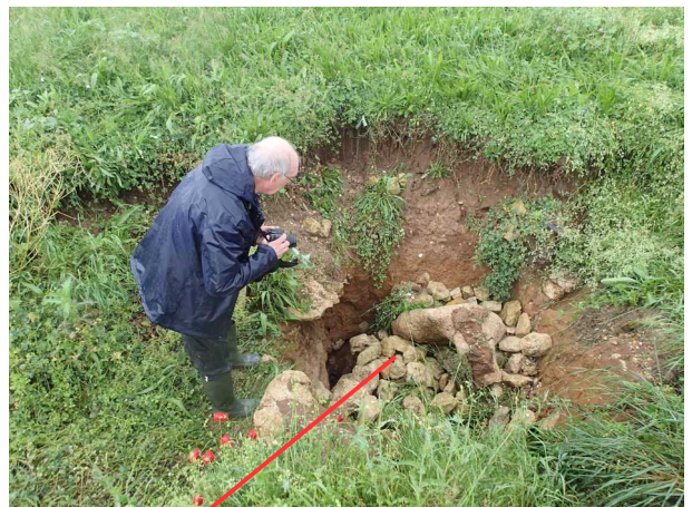
Illustration 1: L'effondrement ; la trémie
