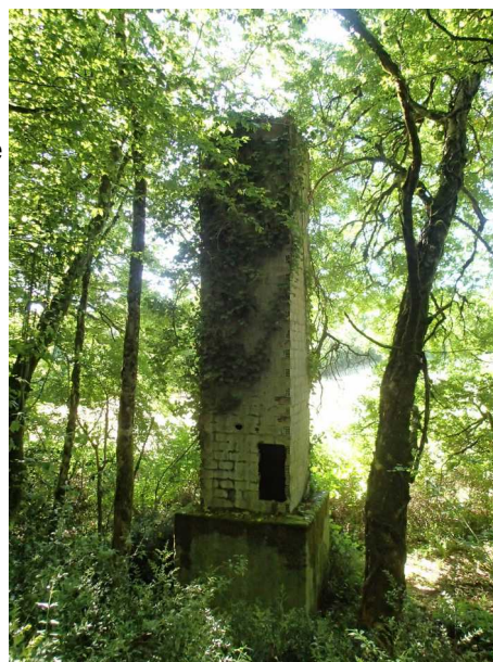
Illustration 1: La cheminée d'aération
