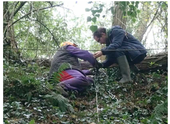
Illustration 3: Mise en oeuvre du tire fort
