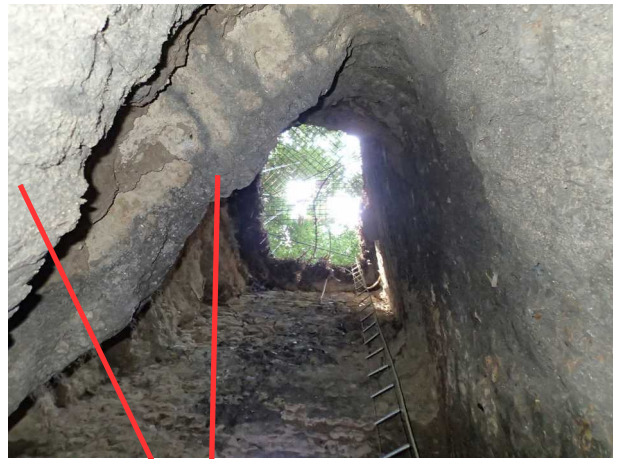
Illustration 2: Vue vers le haut à partir du fond du puits. Au premier plan la roche massive
