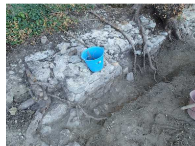
Illustration 3: La base du mur nord dégagée
