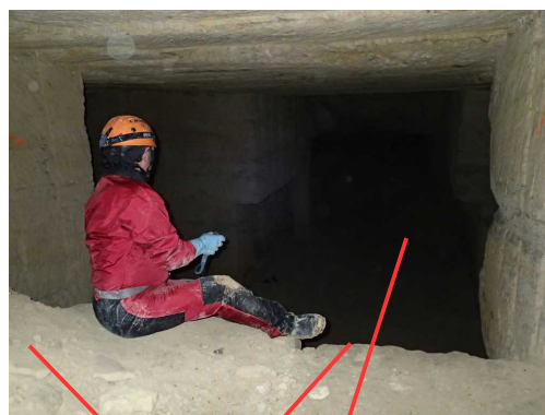
Illustration 10: Un des dangers du réseau : la galerie supérieure qui domine la carrière inférieure par un ressaut de 2m
