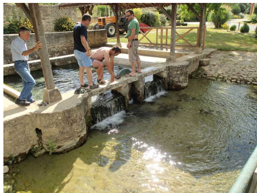
Illustration 1: Préparation de la vidange du bassin. Levée de la vanne.
