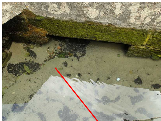
Illustration 3: L'alimentation de la source, l'eau arrive par la fissure sombre en haut à gauche de l'image.
