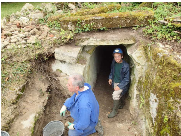
Illustration 5: L'entrée du souterrain, les travaux de nettoyage
