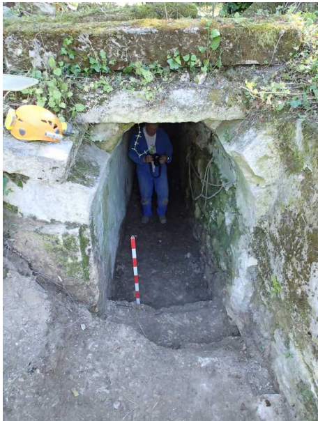
Illustration 4: L'entrée du souterrain dégagée des constructions du 20ème siècle : toilettes, caniveau d'évacuation, remblais cimenté, etc...
