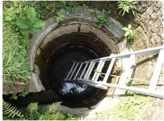
Illustration 4: Une des 3 cuves qui contenait la roue d'énergie.
