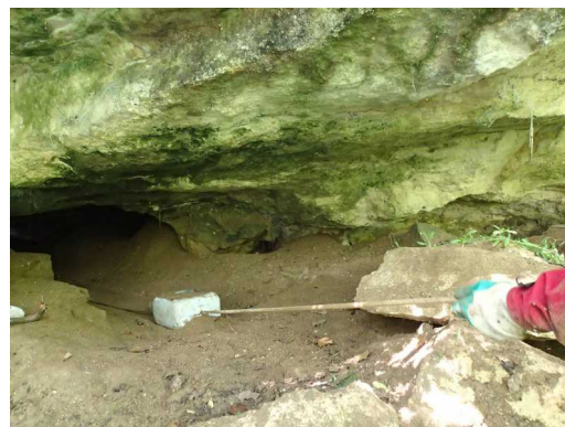
Illustration 1: Extraction de la navette pleine de terre. La corde vers le spéléo à l'intérieur permettra de ramener la navette vers la zone des travaux.
