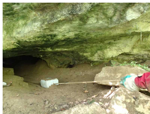
Illustration 1: Extraction de la navette pleine de terre. La corde vers le spéléo à l'intérieur permettra de ramener la navette vers la zone des travaux.
