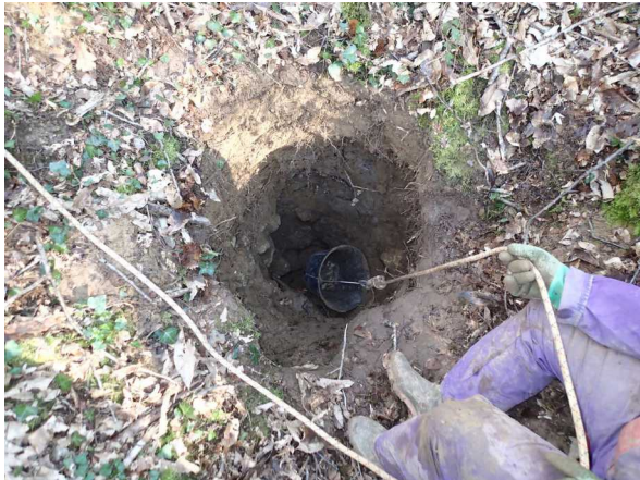
Illustration 6: Vue générale du puits agrandi, à la fin des travaux
