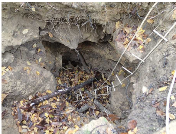
Illustration 2: Le fond du puits avant les travaux de cet après-midi
