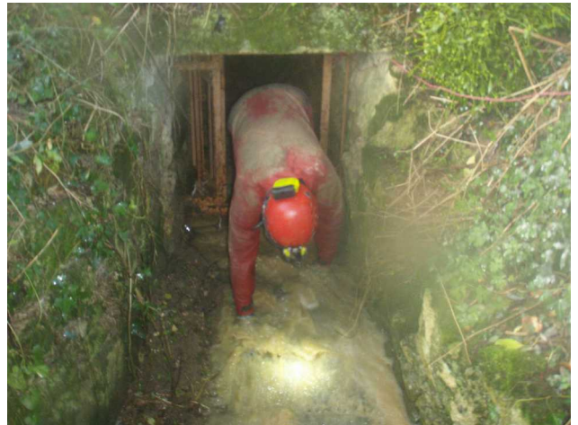
Illustration 12: L'aqueduc d'entrée et le ruisseau de crue
