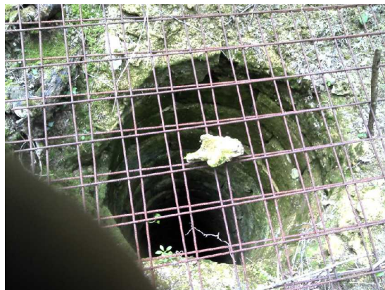
Illustration 8: L'entrée du puits d'aération
