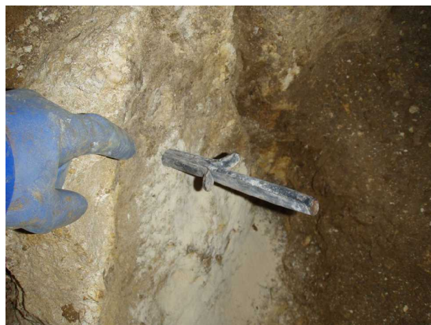
Illustration 3: Un aspect du forage et de l'éclateur, pas complètement en place. Il nous faudra améliorer notre technique.
