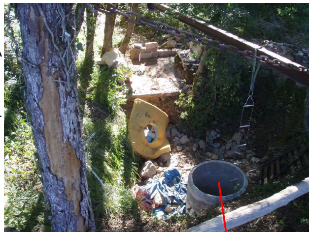
Illustration 1: L'installation est prête à fonctionner. La descente dans l'aven se fait dans les buses.
