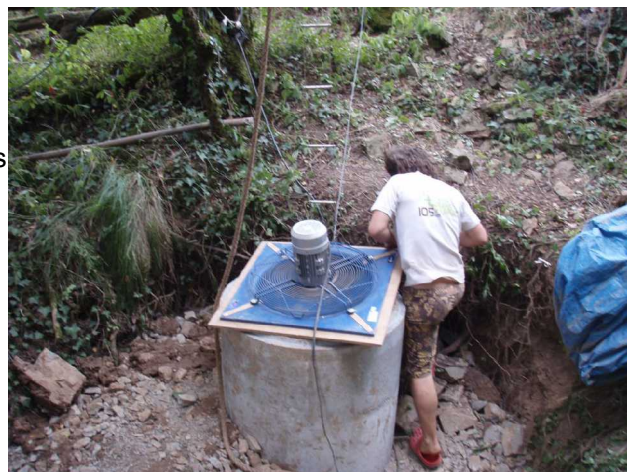
Illustration 1: La doline aménagée, les buses et le ventilateur.
