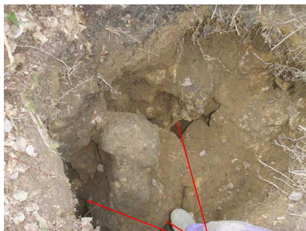
Illustration 7: Vue d'ensemble de la trémie à dégager. La suite et le vide.
