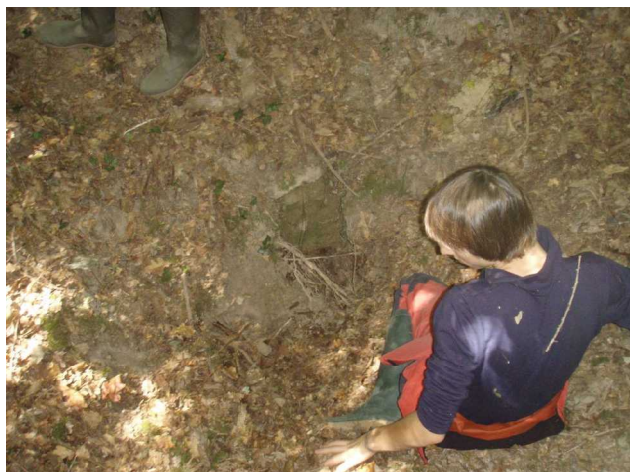
Illustration 3: L'effondrement avant les travaux
