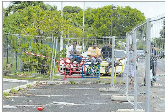
Les jeunes ont assisté à la démolition du lieu.
