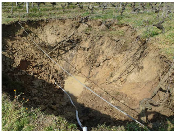
Illustration 9: à 12h 30 : fin du pompage
